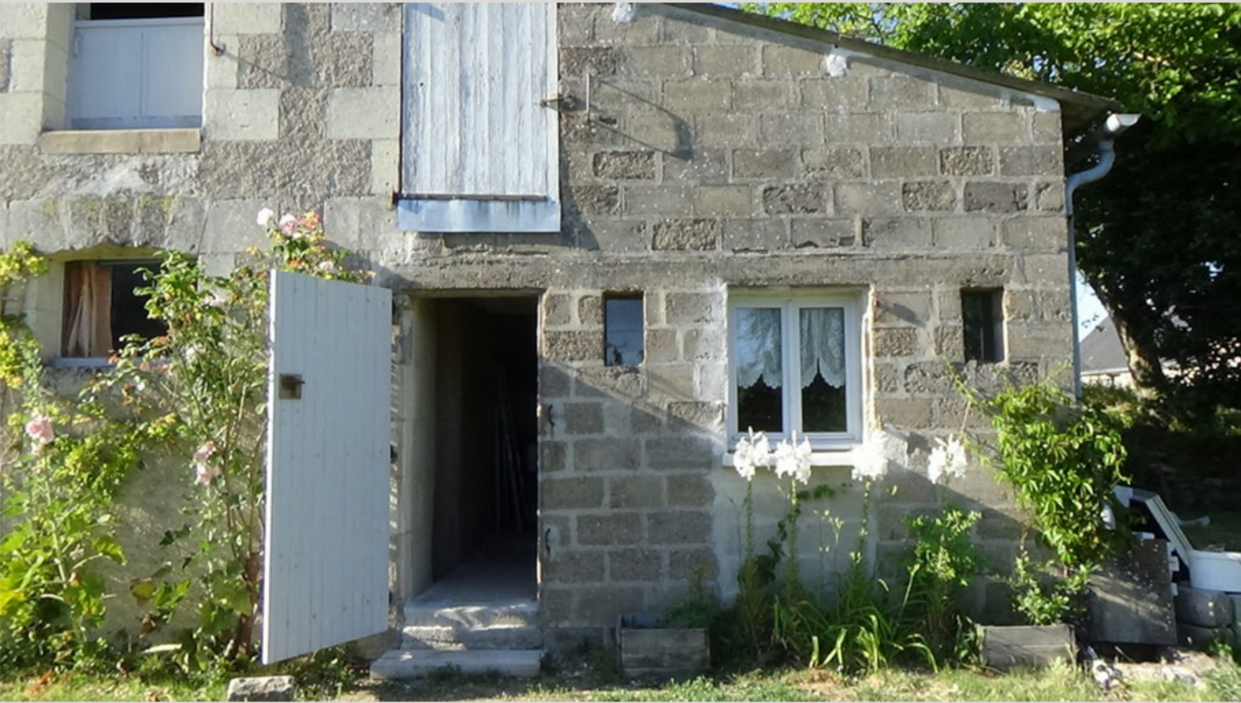
Façade Sud petite écurie au 01/06/2020
